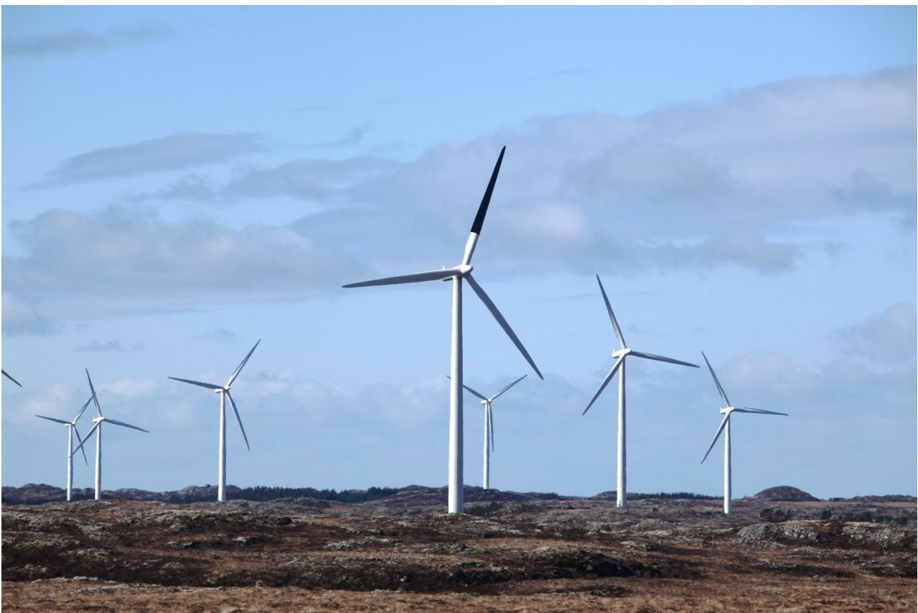
Figur 8-3: Rotorblad malt med svart farge for å redusere fare for fuglekollisjoner
