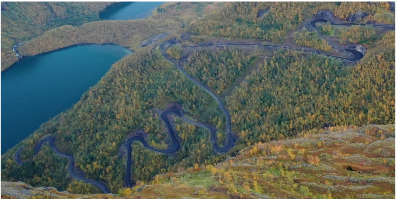
Figur 6-3: Transport på bratt, smal og svingete atkomstvei som opprinnelig ble bygget for et vannkraftverk, Bruk av denne veien som adkomst ble satt som en forutsetning for å tilby turbinleveranse.
