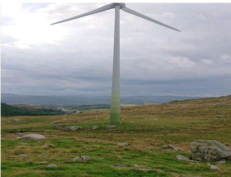
Figur 8-2: Sauebeite rundt vindkraftverk. Sauer beiter på kranplassen som er dekket med gress.
