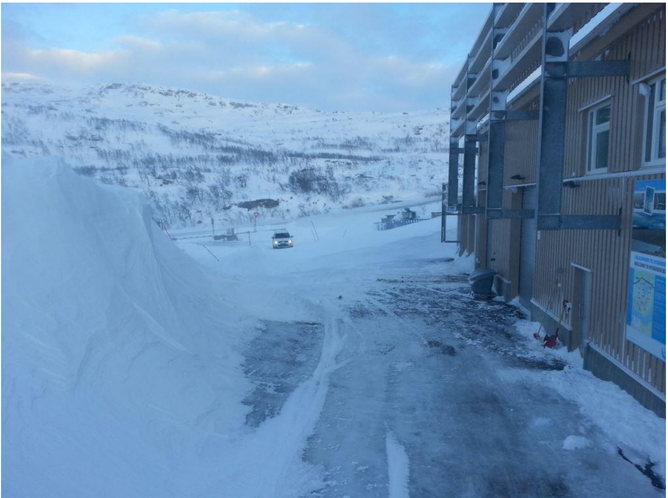
Figur 6-13: En enorm snøfonn danner seg i god avstand til driftsbygningen i denne vindparken. I hovedsak feier vinden inngangen fri for snø. Da bygget ble gjort om til driftsbygg ble det installert levegger på taket for å «flytte» snøfonnene bort fra bygningen. Ved prosjektering av et nytt bygg ville man kunne finne en integrert løsning allerede i starten.
