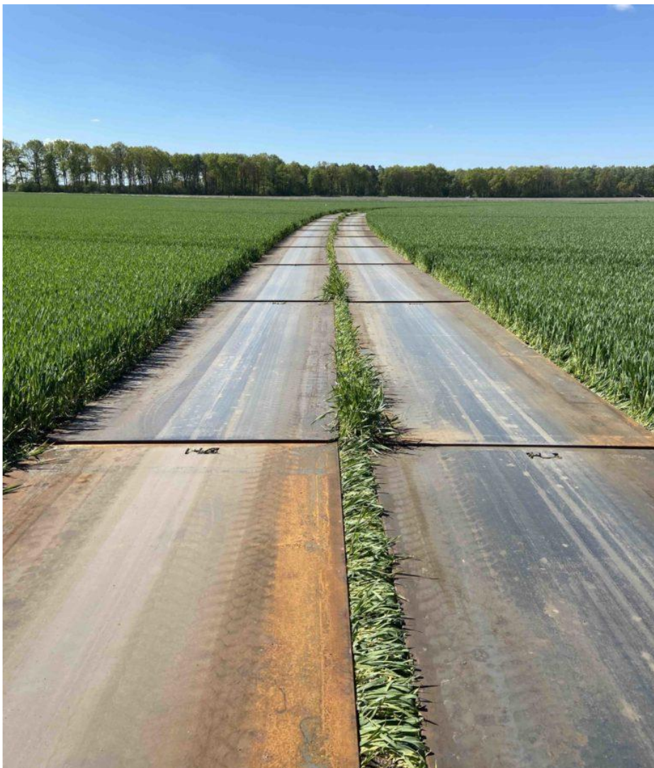
Figur 6-10: Lager for turbinblader på et jorde - stålplatene blir fjernet etter bruk
