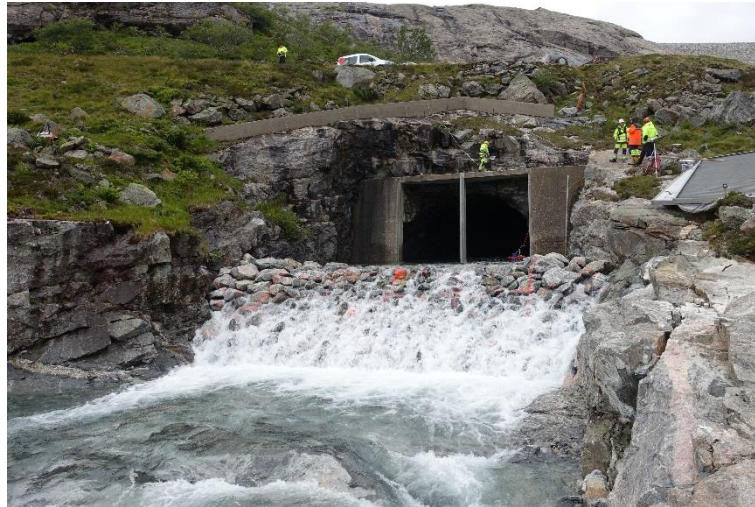
Figur 6 Testdam med plastring (F15P2 i 2015). Krona til dam Svartevatn er synlig øverst til høyre i bakgrunnen av bildet (Foto: NTNU).
