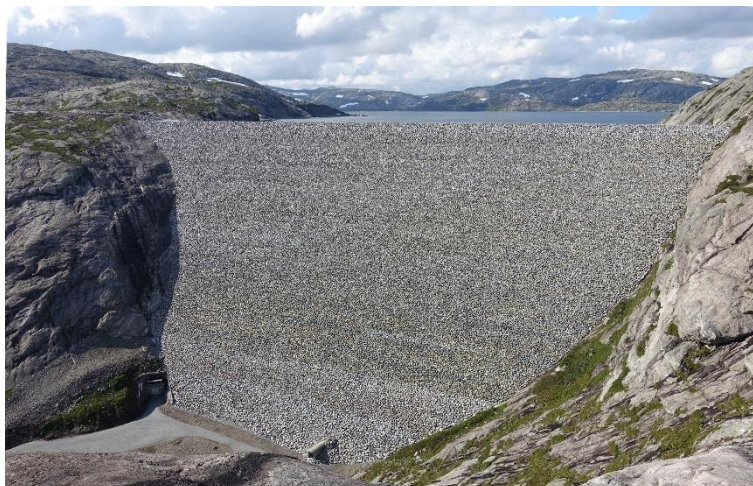
Figur 1 Dam Svartevatn som var ferdigbygd i 1976 og med 129 m høyde den høyeste dammen i Nord-Europa på denne tiden. Bildet viser dammen etter rehabilitering i 2015. Nedstrøms skråning er dekket med plastring (Foto: P. H. Hiller).
