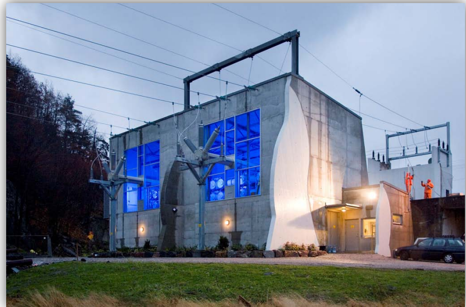
Torbjørnsbu Transformatorstasjon, Arendal
