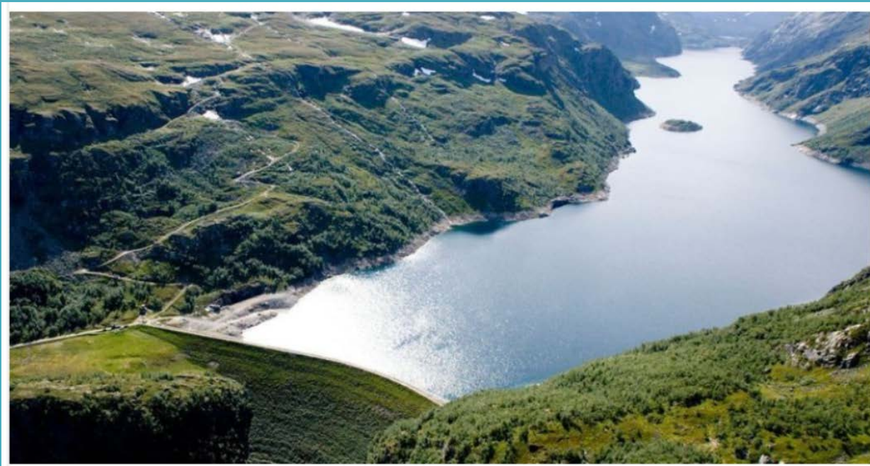
Dam Viddalsvatn i Låvisdalen i Aurland kommune, bygget 1970-197 (Foto JHafslund Eco)
