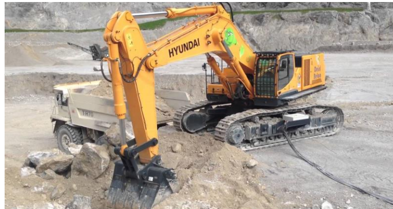
Foto: Mörtelbauer Baumaschinen
