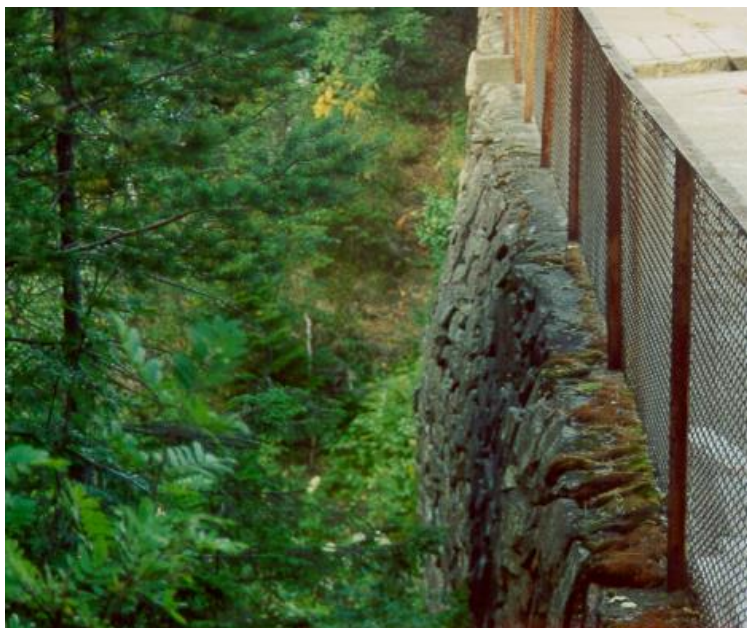
> Figur 8-1. Utbuling nedstrøms side.
