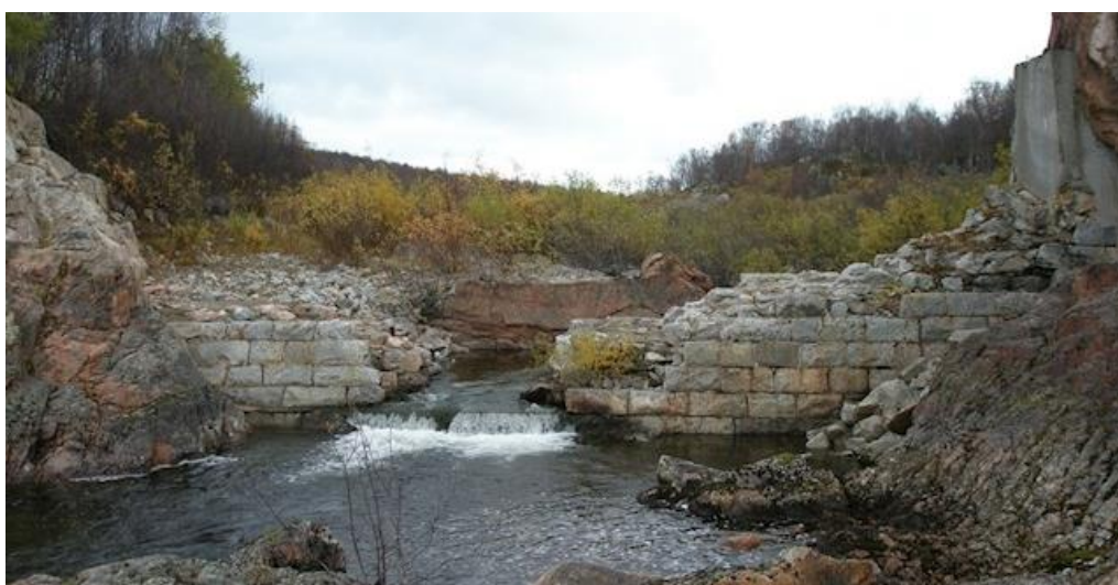
> Figur 3-14. Dam Tårnet i dag. (Foto: NVE)
