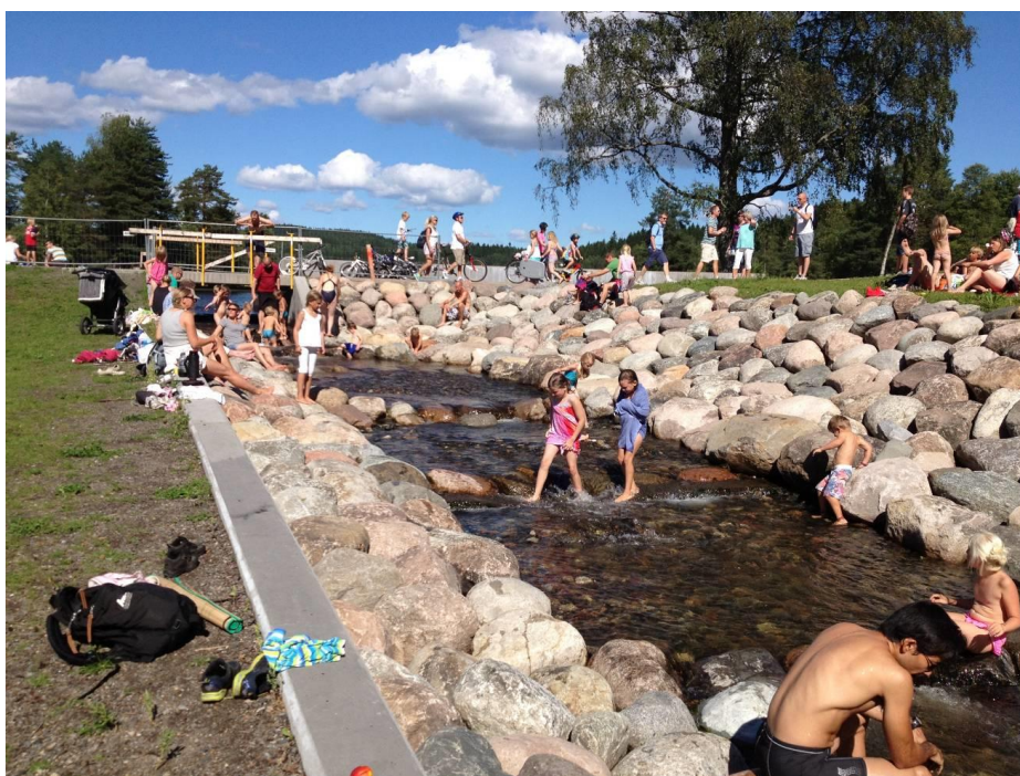
> Figur 8-24. Flomløp 2 med vandringsvei for fisk.
