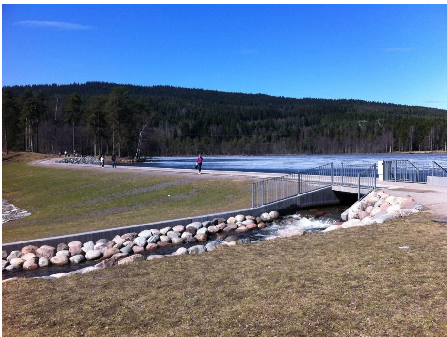
> Figur 8-23. Ny dam Sognsvann. Flomløp 1 nærmest i bildet, mens flomløp 2 over fyllingsdammen er lagt mot venstre vederlag.
