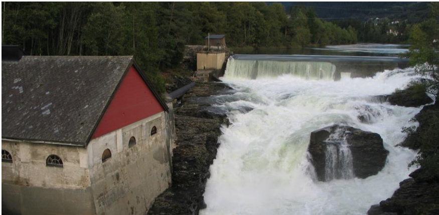
> Figur 8-8. Dam i normalsituasjon.
