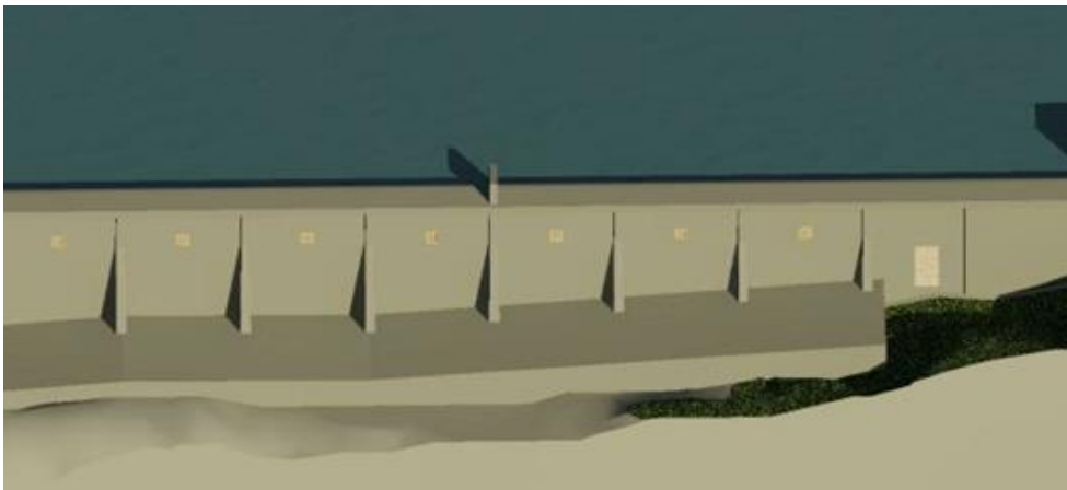
> Figur 8-29. Overløpsdammen med sokkelstøp.
