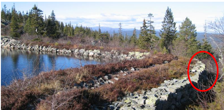
> Figur 8-6. Område for utbuling/deformasjon.
