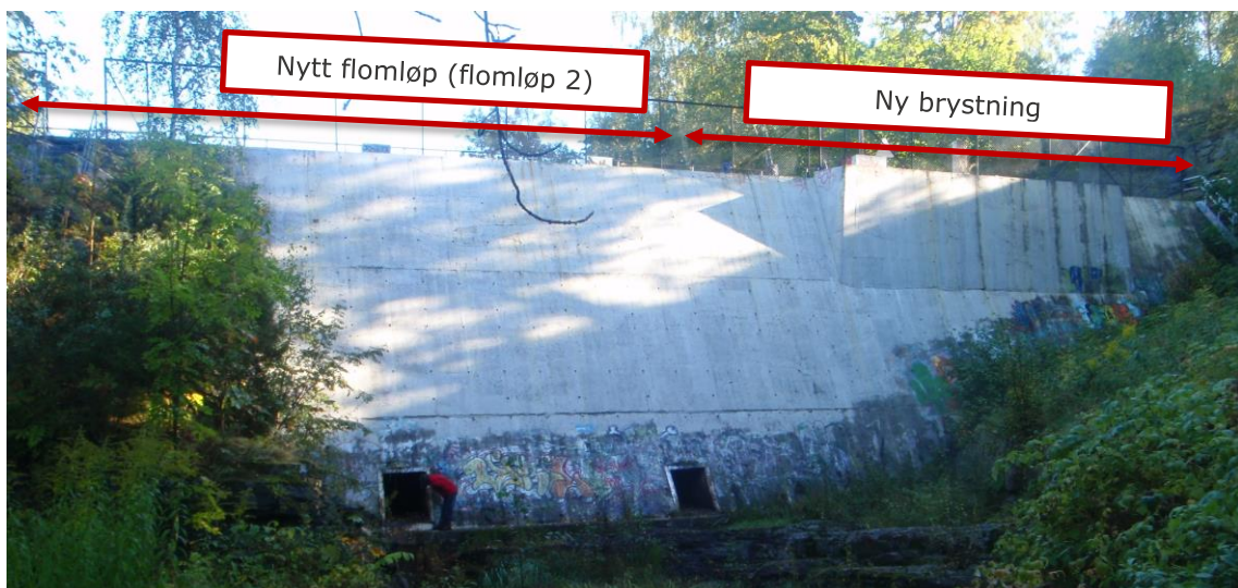
> Figur 8-17. Glitteruddammen, luftside med angivelse av tiltak.
