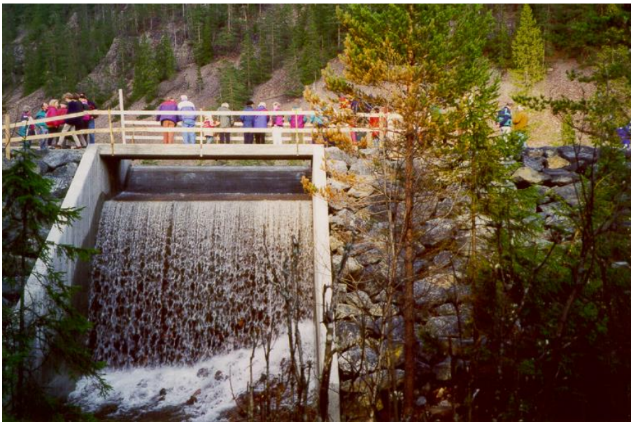
> Figur 8-25. Strømsdammen etter ombygging.
