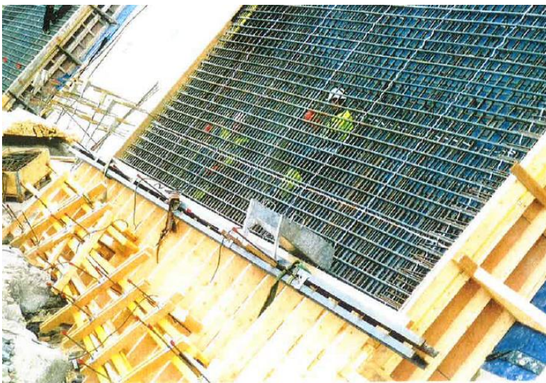
> Figur 8-36. Utbedring av dam Votna II.
