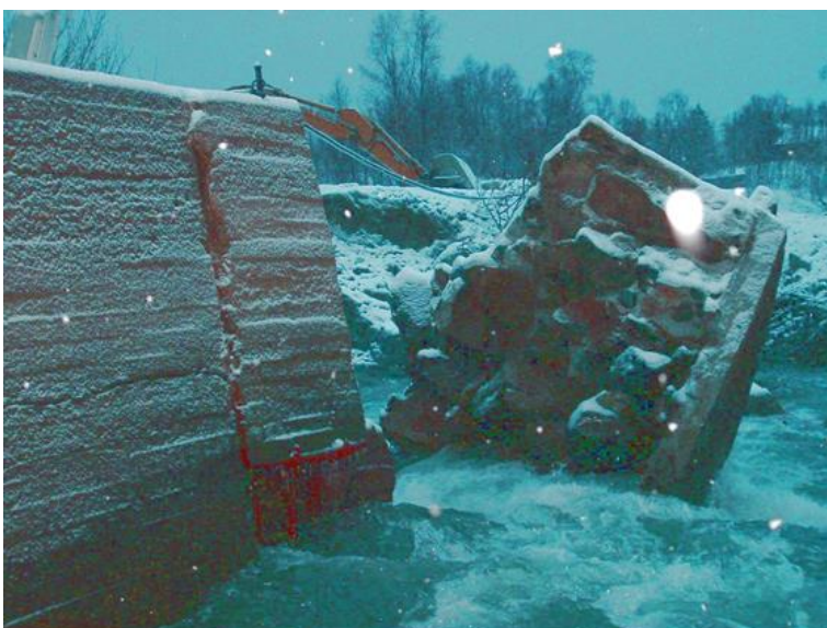
> Figur 3-10. Dam Blokken, 2002 (Foto: NVE)
