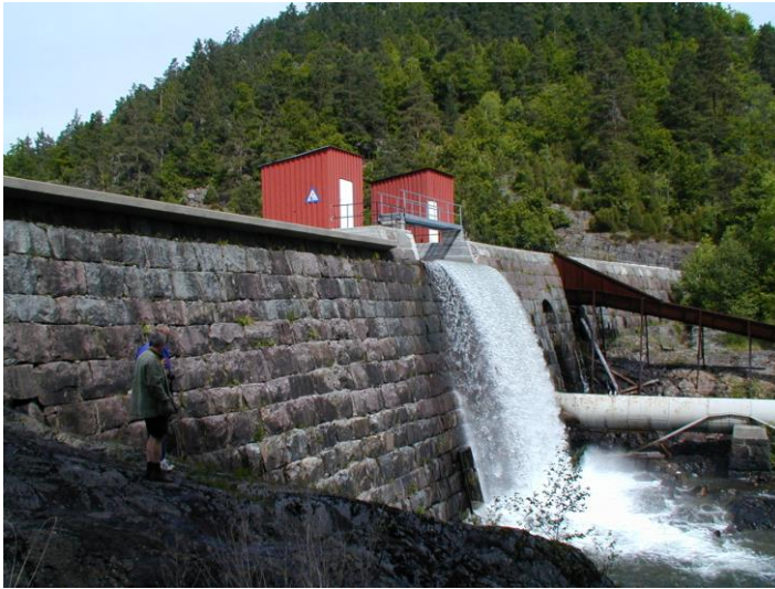
> Figur 8-21. Dammen etter ombygging.
