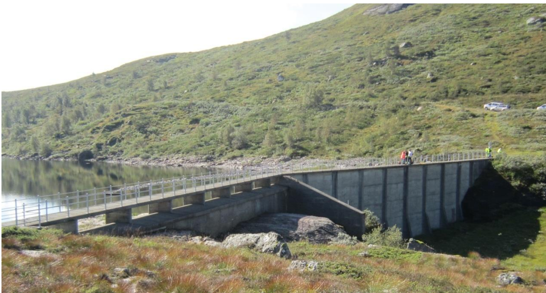
Figur 8-37. Dam Krokavatn før forsterking.
