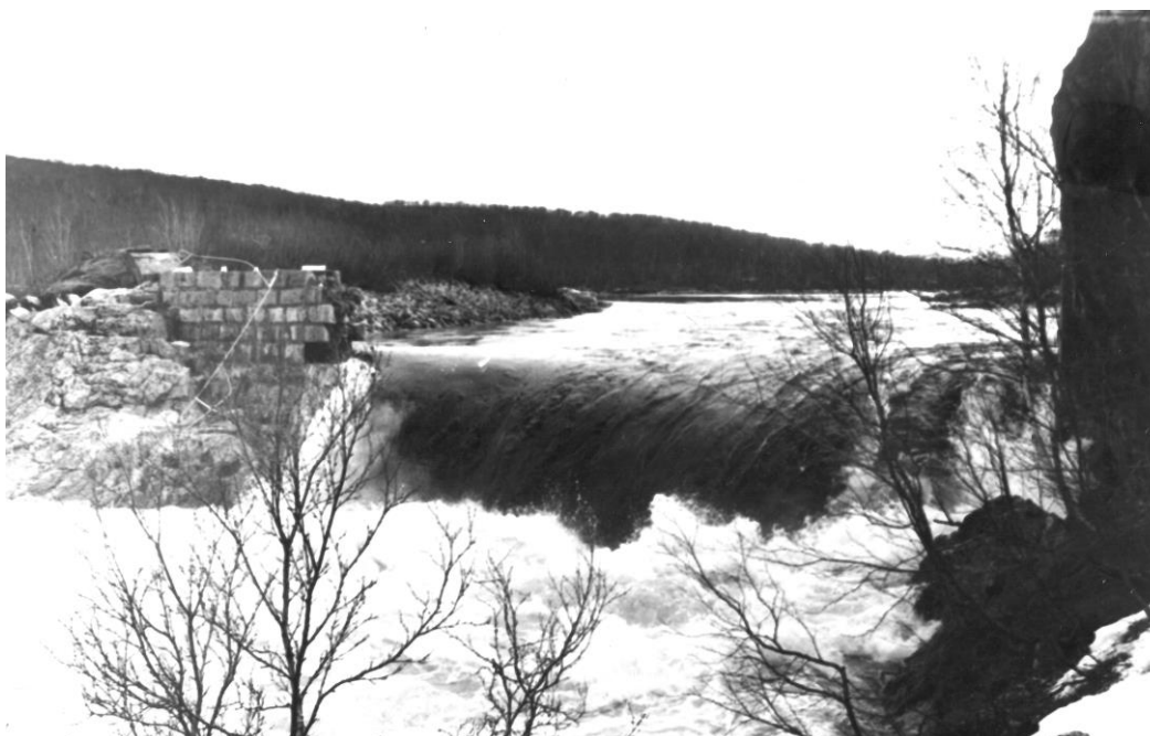
> Figur 3-12. Dam Tårnet, 2 timer etter bruddet i 1979 (Foto: NVE).
