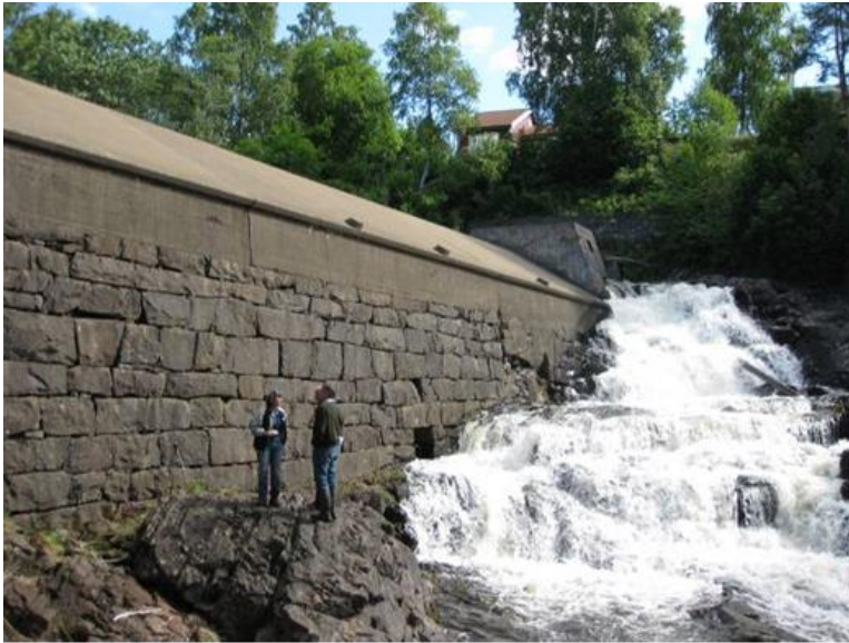
> Figur 8-14. Luftside av Grinidammen
