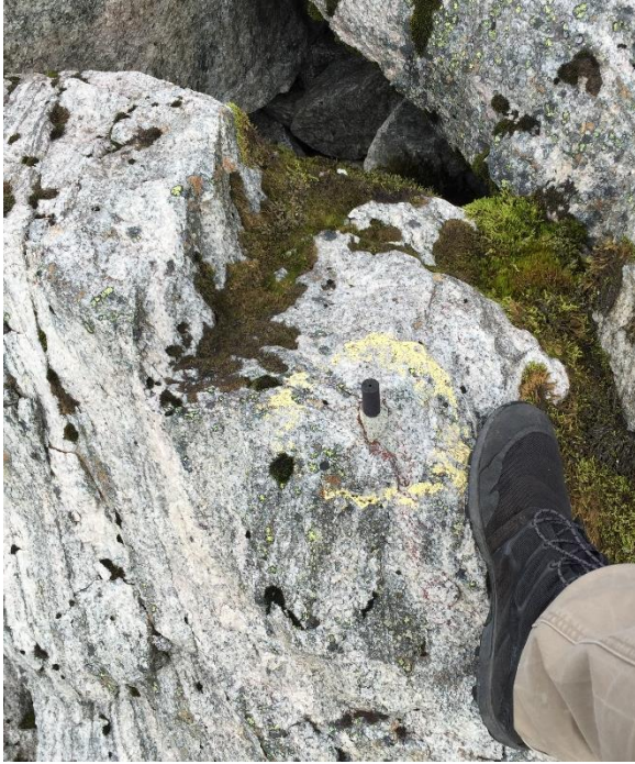
Figur 3 Eksempel på skråningsbolt i nedstrøms damskråning.
